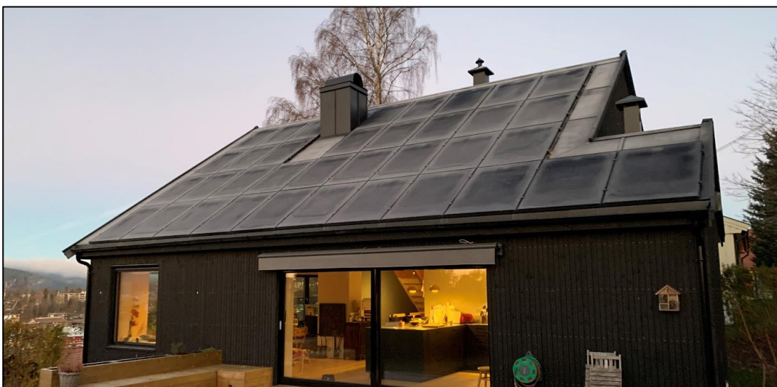
Figur 3-3. Eksempel på integrerte solceller (BIPV) hvor solcellene utgjør taktekkingen. Foto: Bjørn Thorud, Multiconsult Norge AS.
