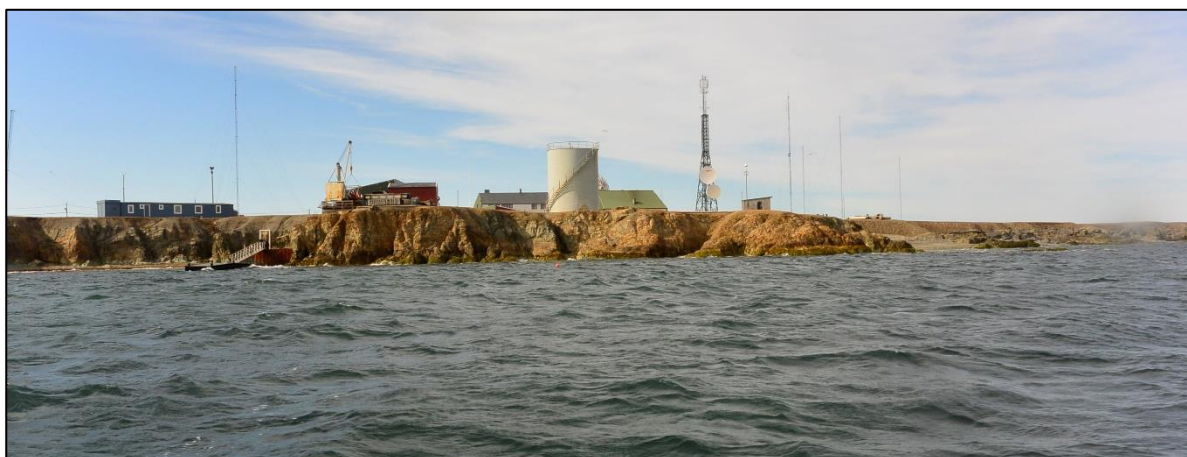
Figur 7-5. Isfjord Radio. Til tross for stor variasjon både i uttrykk og i fargebruk må man i dette storskala landskapet være relativt tett på før bygningsmassen virker dominerende i landskapsbildet. Her sett fra fjorden mot vest, på vei inn i Randvika, et bilde som møter de som ankommer Isfjord Radio sjøvegen. Foto: Hilde B. Johnsborg, Multiconsult Norge AS.
