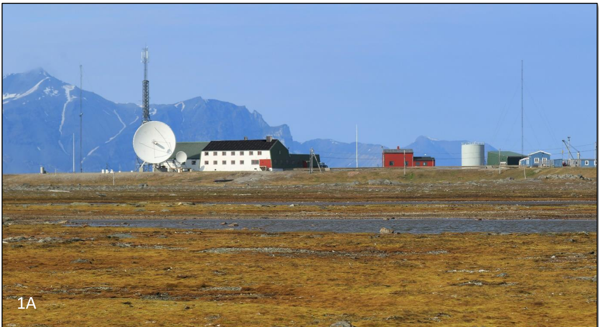
Figur 7-23. Virkningen av solceller på enkelte av takplatene vil bli den samme herfra som sett fra motsatt side i delområde II. Bildene viser eksisterende bebyggelse ved Isfjord radio som den fremstår i dag, samt med ett mindre rustikk preg, med solcellepanel som får takflatene til å fremstå som nye.
