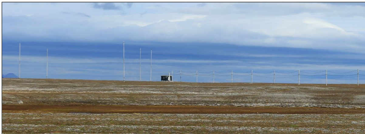
Figur 7-1. Telenors bygg og master på Randvikodden, samt eksisterende kraftledning inn til Isfjord Radio. Høyden på mastene er av Telenor anslått til 13 - 18 m. Til sammenligning vil et bakkemontert solkraftanlegg ha en høyde på ca. 2,5 m, mens vindturbinene som er brukt som eksempelturbiner i denne utredningen har en høyde på 49 - 75 m. Foto: Kjetil Mork, Multiconsult Norge AS.
