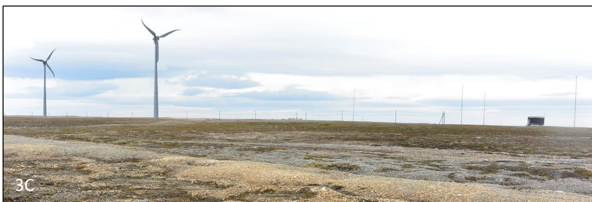
Figur 7-19. De ulike alternativene vist på bilde tatt ved Telenor sitt anlegg på Randvikodden. For alternativ 3C vil den 3. turbinen ligge like utenfor venstre billedkant. Ettersom den ene turbinen i alternativ 2 er plassert omtrent som den midtre av de tre turbinene i alternativ 3, medfører det at den nærmeste av de tre turbinene vil virke minst like dominerende som den ene turbinen gjør. På langt hold vil høydeforskjellen spille mindre rolle. Tre turbiner medfører med det en større påvirkning på landskapsbildet uavhengig av avstand. Ettersom Xant-turbinen har ett betong fundament mens Vergnet turbinen er fastspent med barduner. Vergnet turbinen har følgelig en lettere konstruksjon og med to blad i stedet for tre, som er mer vanlig, har den lette konstruksjonen mer fellestrekk med eksisterende telemaster i området.
