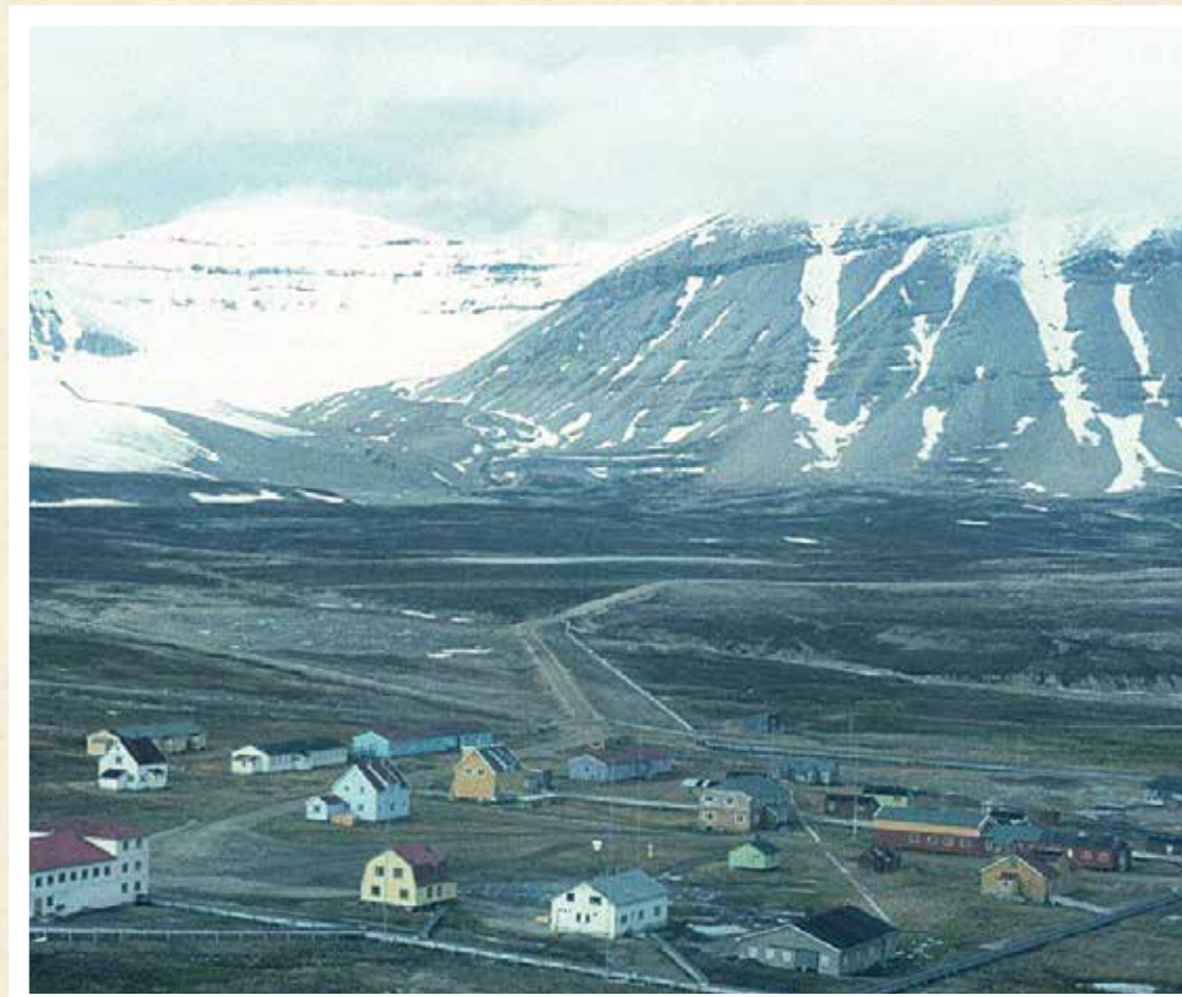
De fem Svenskebrakkene på 1970-tallet. Sibir N, som nå er borte, ligger bak det hvite huset til venstre. Den hvite brakken er sykehuset 27 med den lyseblå Mexico 26 til høyre. Midt på bildet ligger den blå Trønderheimen 25. Samfunnshuset 28 er den røde til høyre i bildet. Den gule veggene kom da taket ble løftet i 1962.
