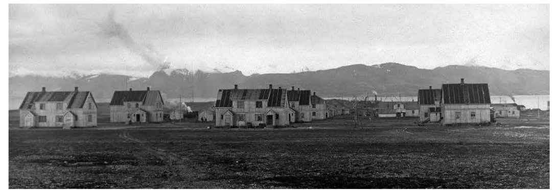
I nærmeste rad fra venstre: funksjonær bolig I , funksjonær bolig H og driftsjefens hus 16 . I raden bak ligger fra venstre sykehuset G , funksjonærmessen 15 og kontoret 17 . Funksjonærboligene og sykehuset ble brent av tyske soldater under andre verdenskrig. Foto: 1920 Erling Einar Angell Thiis, Norsk Polarinstitutt.
