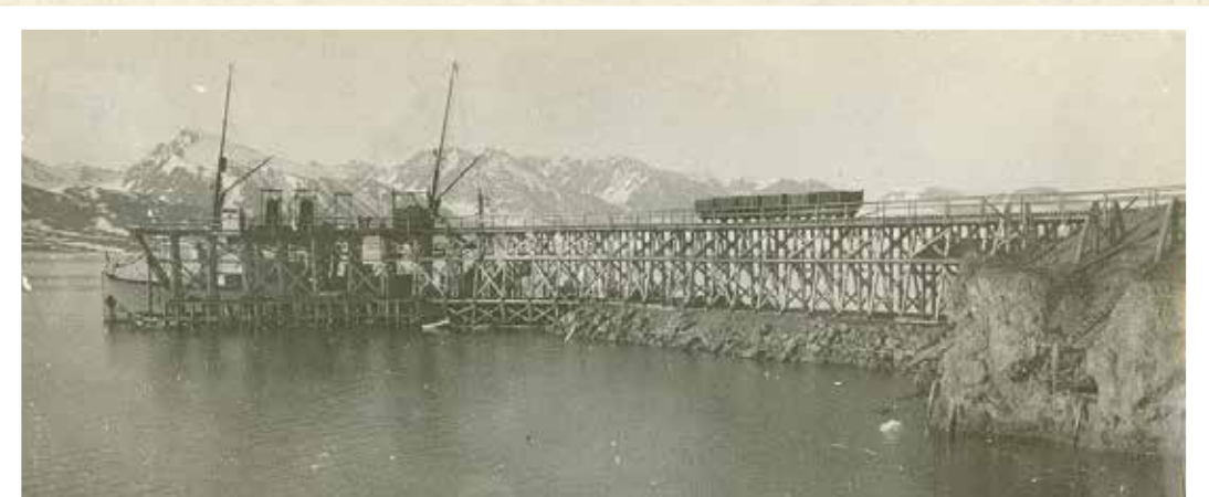
Kullkaia i 1925. Den ligger der dagens kai 53 er. Oppå kaia står det kullvogner. Et skip får lastet kull fra lasterennene. Foto: Helge Hjelle, Norsk Polarinstitutt.
