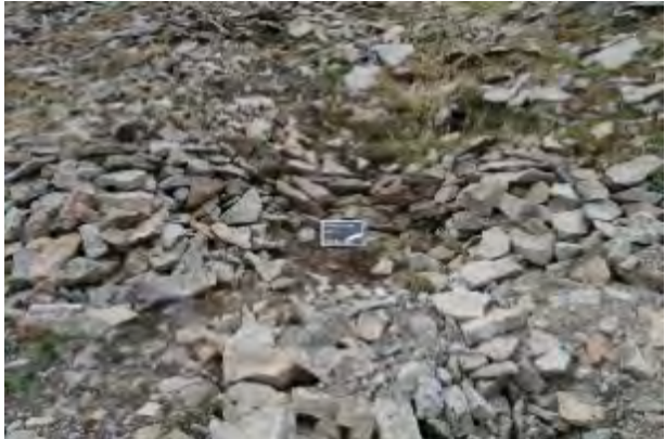
Figur 2: Arbeidsflate vest for gruveåpningen. Tørrmurt støttemur i bakkant.
