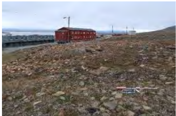
Figur 4: Grunnmur S-Ø-hjørnet, mot SV.
