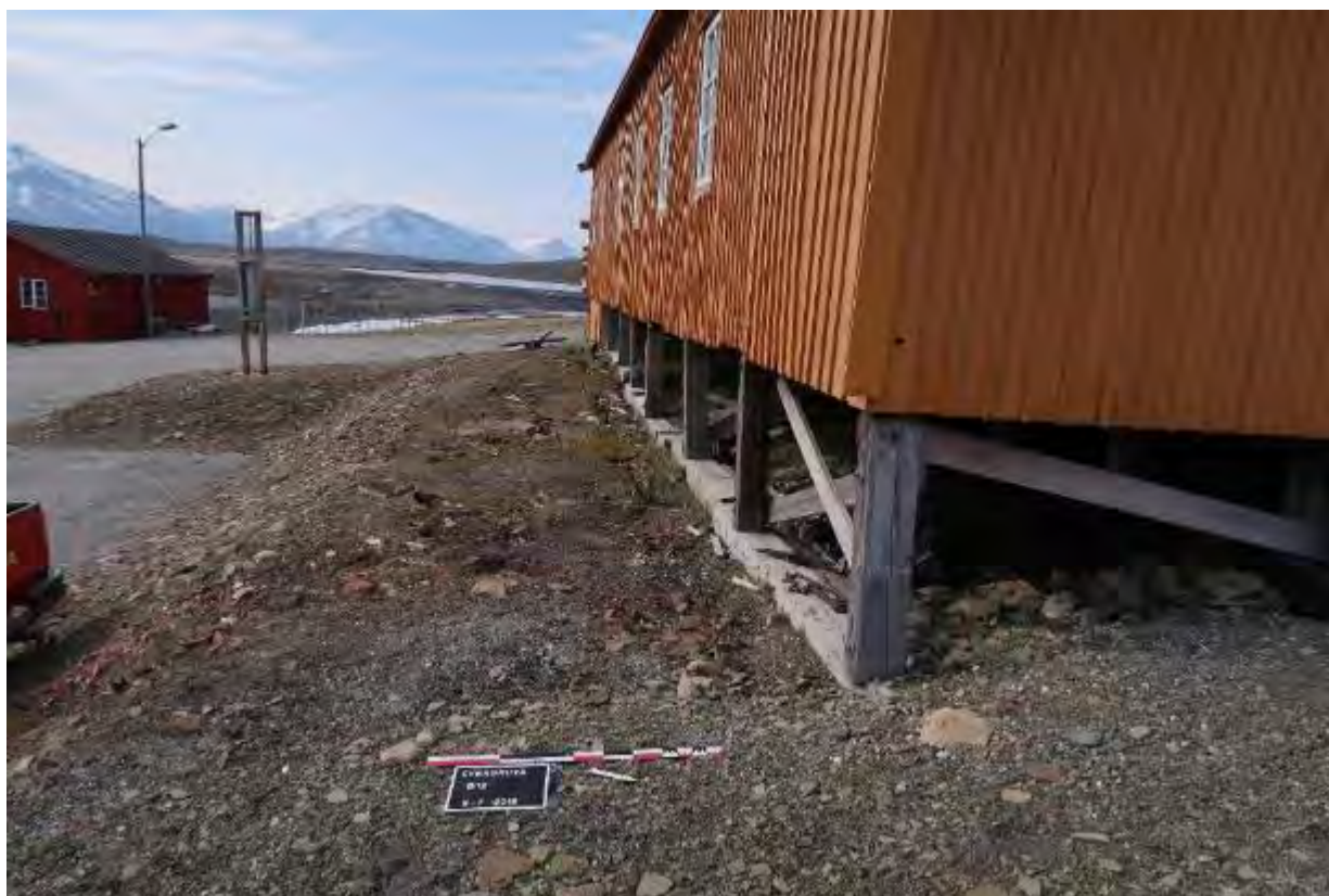
Figur 1: Oversiktsfoto av tuftens utstrekning utenfor stående hus. Mot S.
