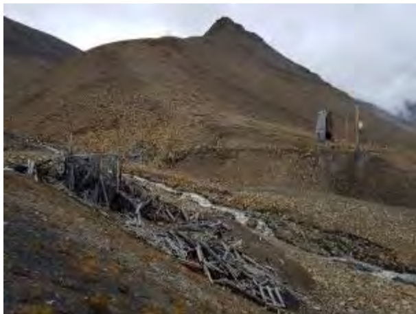
Figur 5: Galleriet sett fra vestsiden av Gruvedalen. Kullsiloen i forgrunnen
