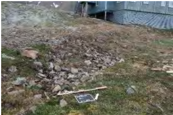
Figur 3: Veien er bygget opp i terrenget.
