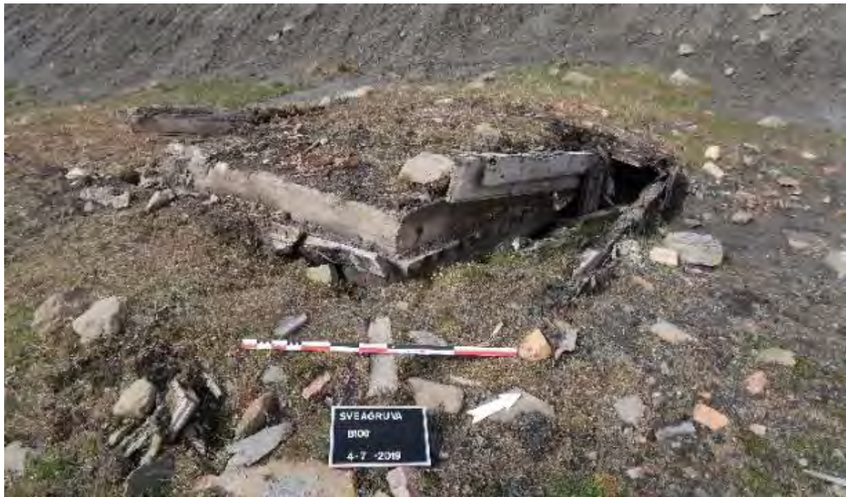
Figur 5: Betongblokk med trevirke som virker å ha falt ned fra stående posisjon. Mot NV.
