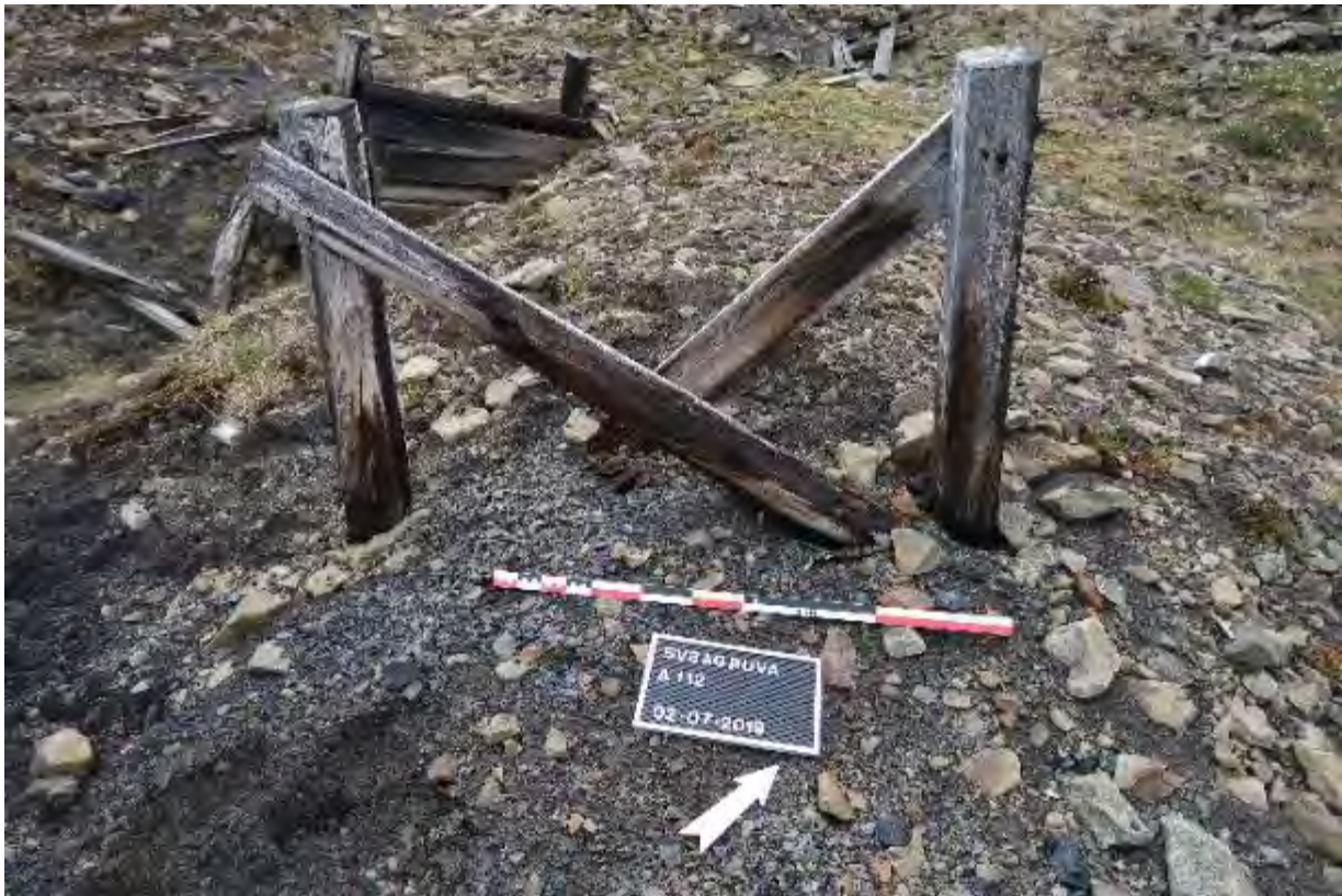
Figur 1: Trebukken bestående av to parallelle trestolper med en kryssavstivning. Trolig fundament for en skinnebane.
