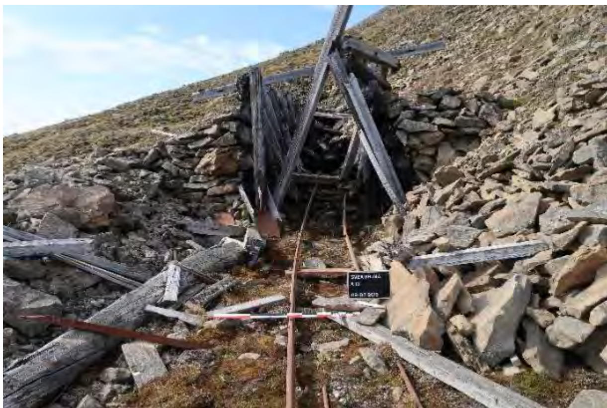
Figur 2: Inngangen med overbygning og skinnegang. Mot VSV.
