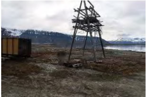
Figur 3: Betongfundamentet er i dag festet til seltårnet. Mot SV.
