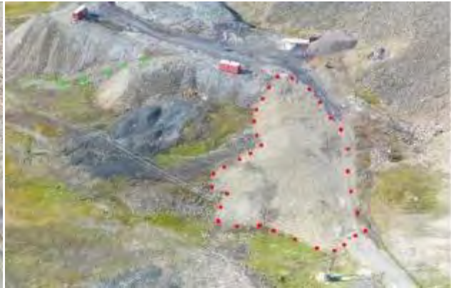
Figur 2: Rød markering viser område med påførte steinmasser. Det er anlagt en nyere vei SØ på tippen markert med grønt. Mot SV.
