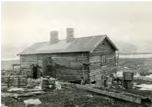
Figur 2: Kontoret under bygging september 1917 (digitaltmuseum.se).
