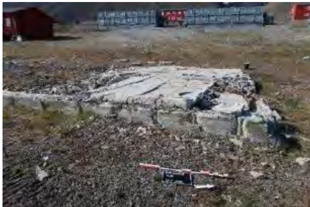
Figur 3: Fundamentets nordlige del, med synlige trestolper. Mot V.
