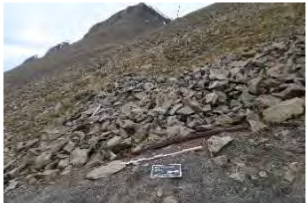
Figur 3: Jernbaneskinne delvis overdekt av rasmasser.
