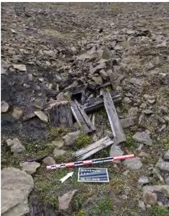
Figur 1: Trebukken bestående av to parallelle trestolper med en kryssavstivning. Trolig fundament for en skinnebane.
