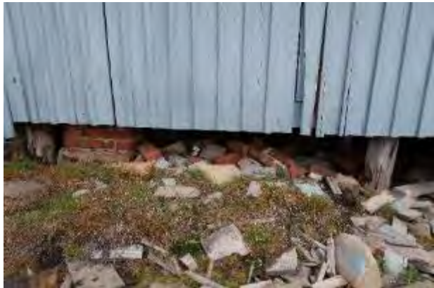
Figur 4: Teglstein ved oppmurt pipe i stående bygning (tidligere id 144344-5).
