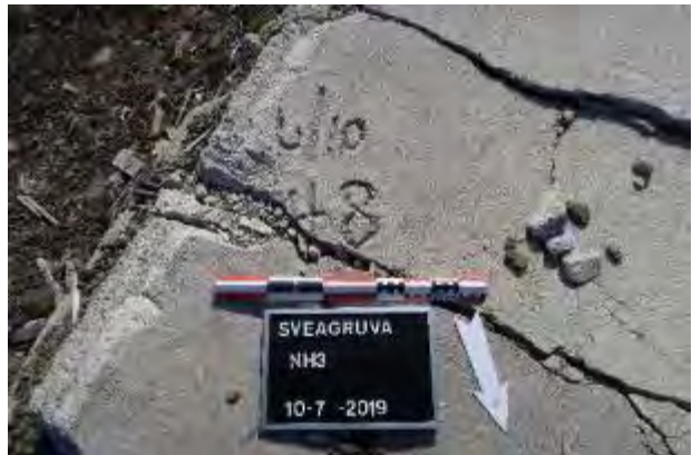
Figur 4: Inskripsjon i betonggulvet: 6/10 48. Mot SSV.
