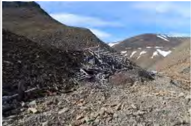
Figur 5: Kullsiloen med det nedre nivået mot elven hvor taubanestasjonen var. Mot N.
