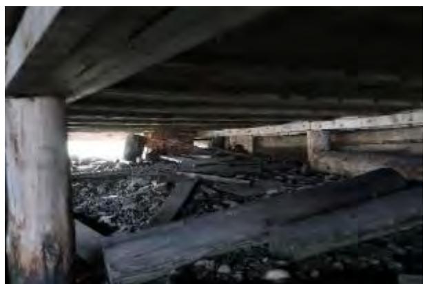
Figur 8: Under stående bygning. Teglstein ved vestveggen (tidligere id 144344-5).
