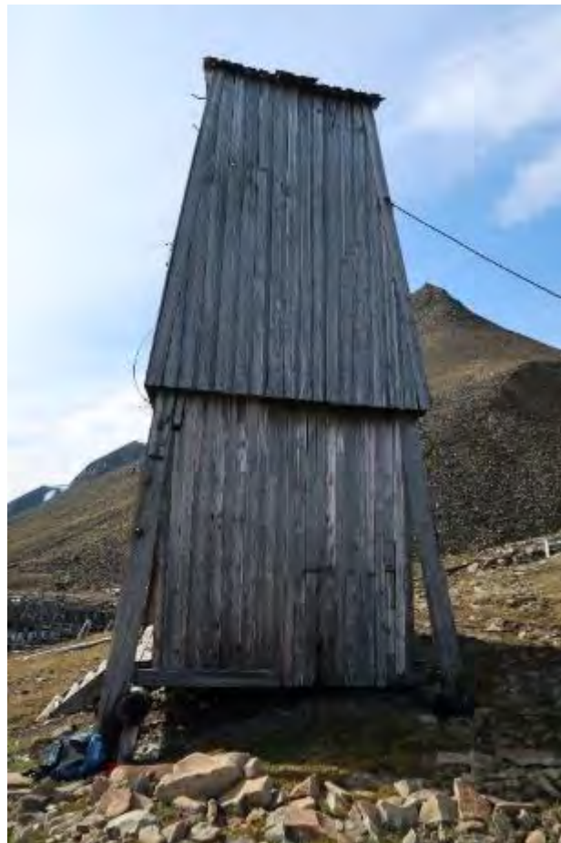
Figur 3: Transformatorårn, fasade mot NØ, tatt mot SV.
