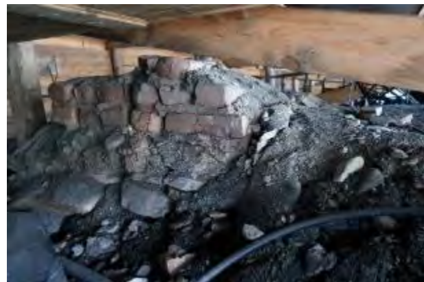
Figur 7: Støpt fundament under stående hus. Lengst mot S.
