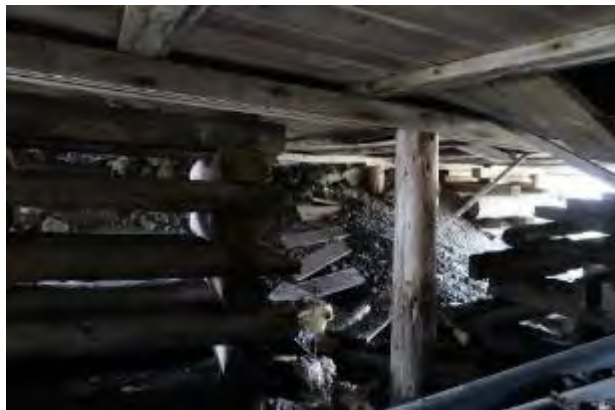
Figur 5: Under stående bygning (tidligere id 144344-5). Støpt mur/betong.
