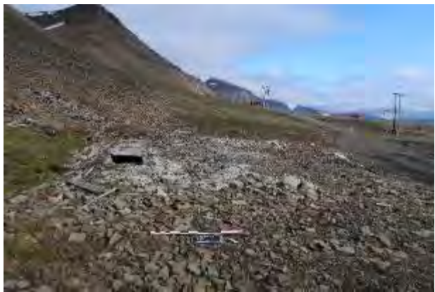
Figur 4: Smøregrav og gulvdekke i betong NØ
