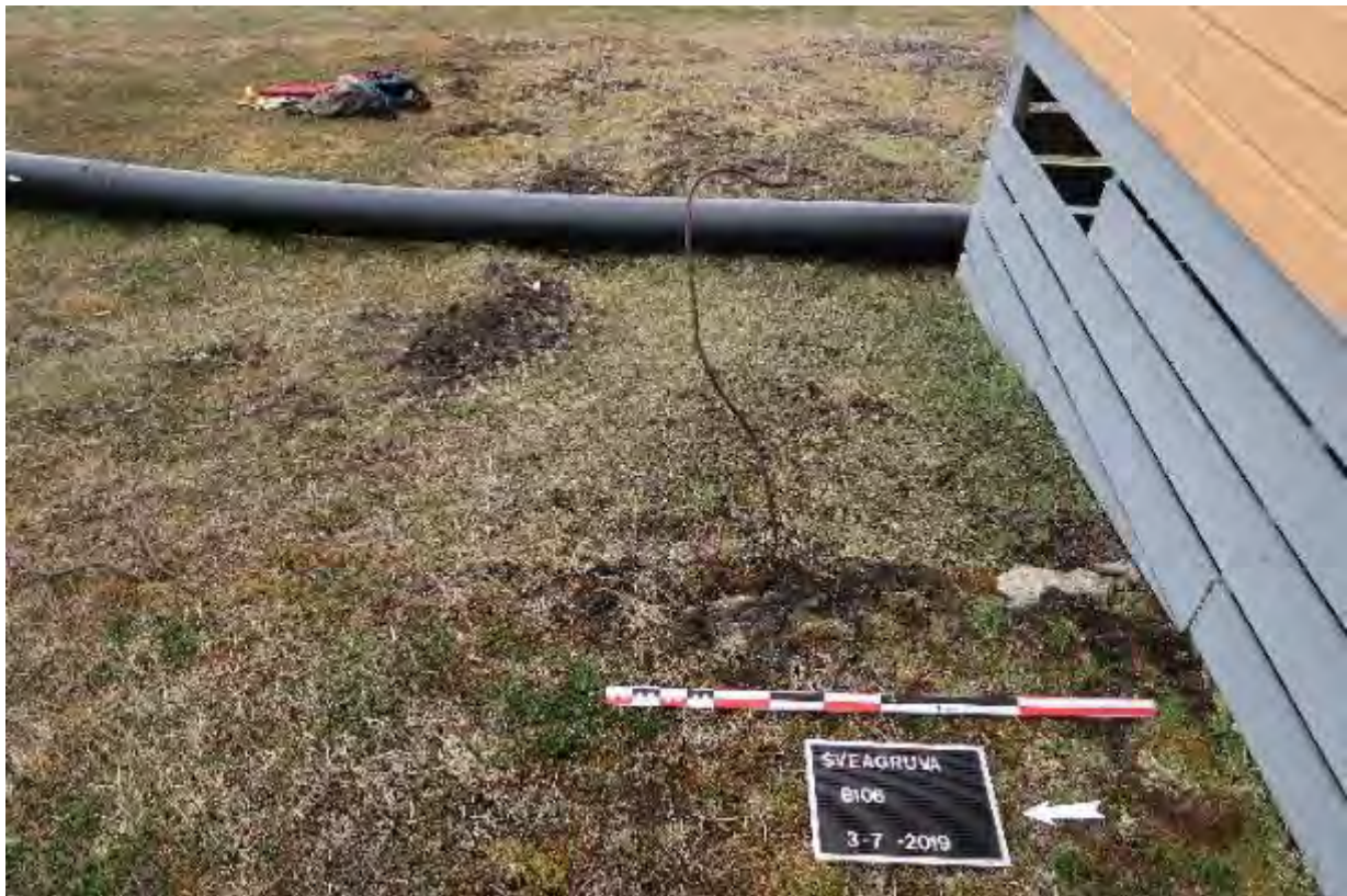
Figur 4: Del av grunnmuren går inn under nyere bygningen. Mot Ø.
