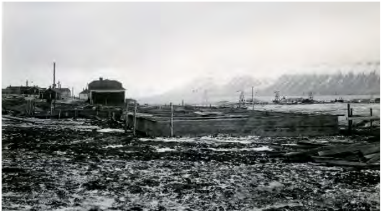
Figur 1: Grunnmuren til funksjonærboligen i 1921. (digitaltmuseum.se)
