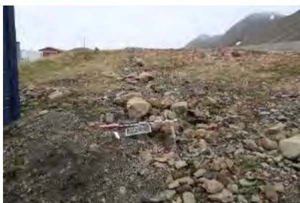
Figur 5: Detalj av enden på langvegg mot Ø. Tuften er ødelagt av masseuttak i hjørnet mot ØNØ. Tatt mot S.
