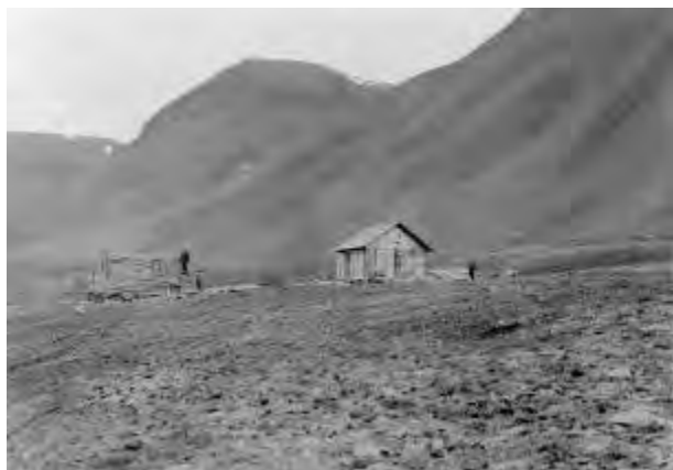
Figur 3: Kontoret under bygging i 1917. Bak står Sykestue/underbefalsbolig (digitaltmuseum.se).
