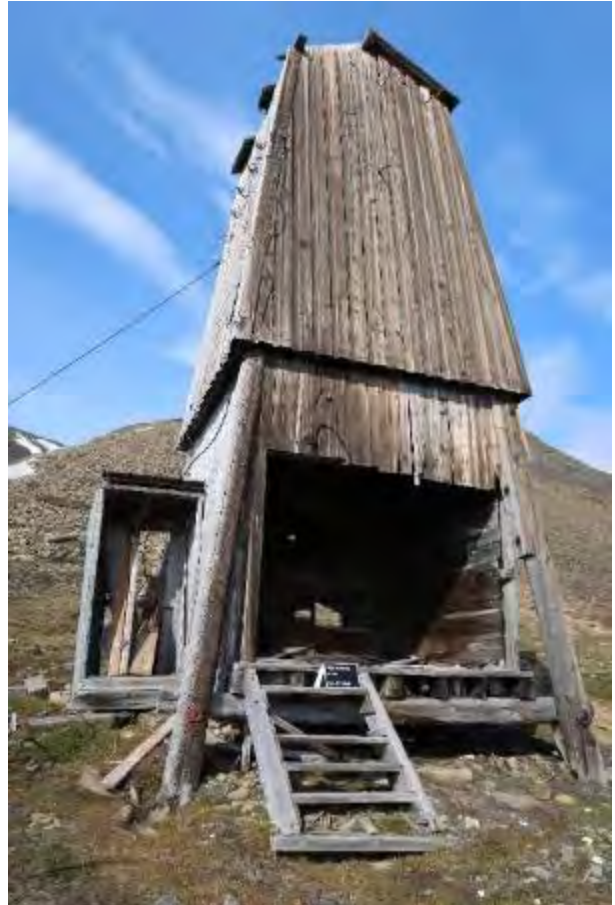
Figur 2: Transformatorårn, fasade, tatt mot N. sideskur sees på byggets vestlige side.
